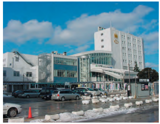
新しくなった八戸駅—右奥は駅ビル
