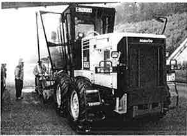
八戸南道路情報化施工実習
